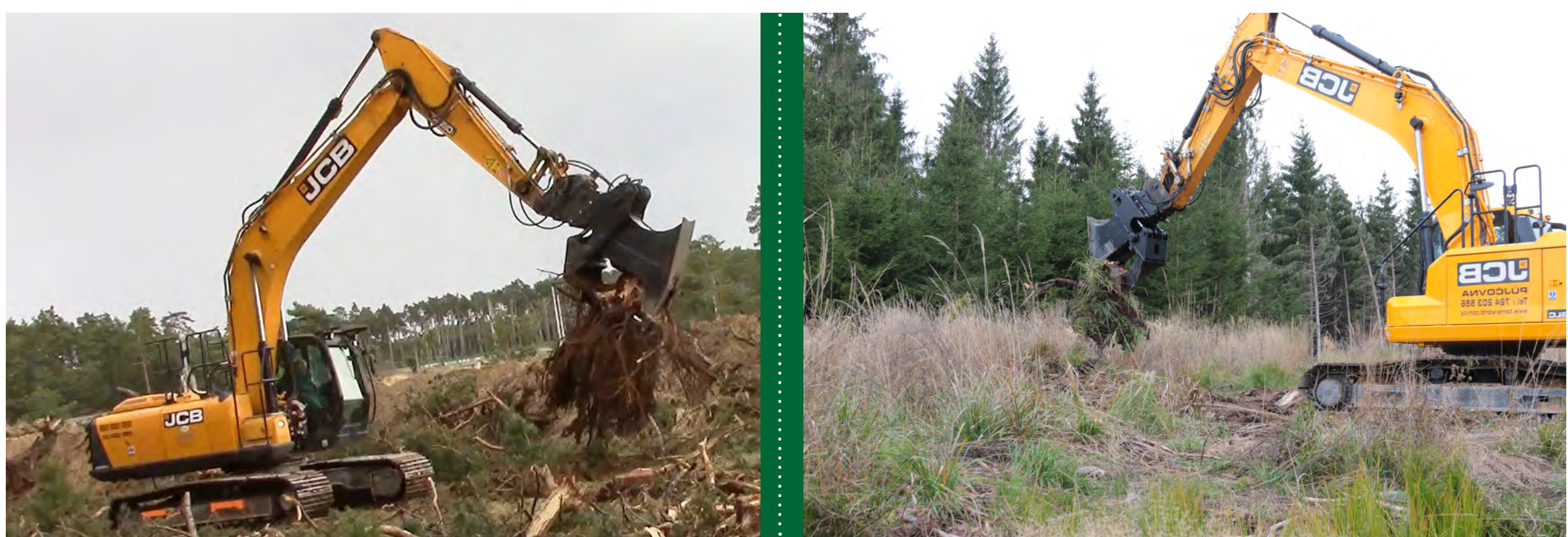
Očistění kořenového systému od zeminy a kameniva
