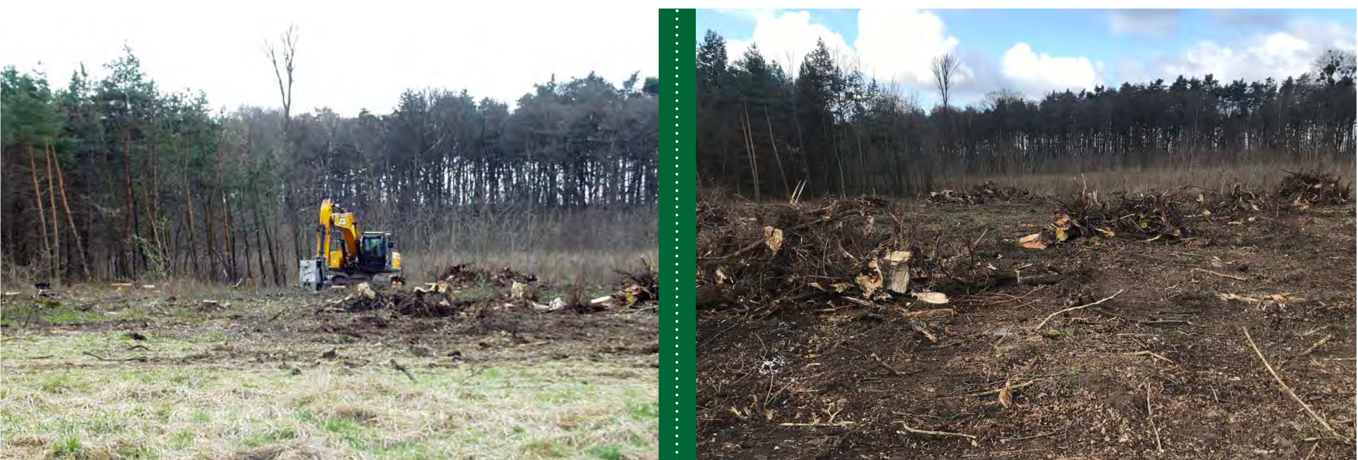
Uložení částí pařezů listnatých dřevin tak, aby to bylo výhodné pro vyvážení z holoseče na odvozní místo
